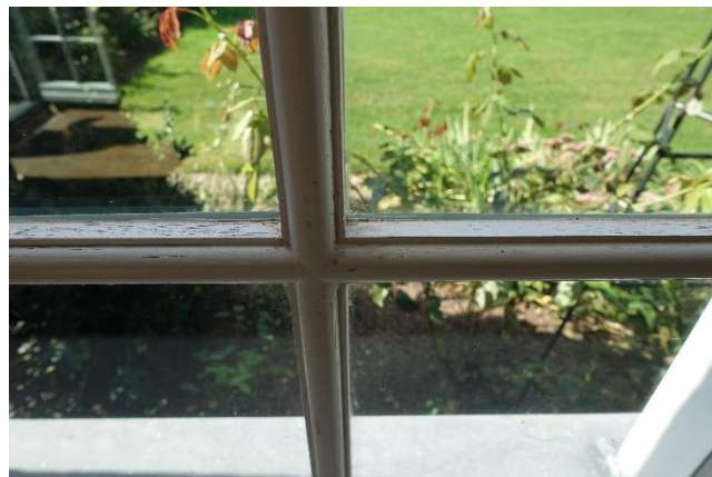
Afbeeldingen 7 en 8: Duurzaam aangepast. De vensters voorzien van gelaagd isolerend (renovatie)glas en van schuifnaar draairaam veranderd, op landgoed Bingerden. (Hielkje Zijlstra TUD, 19 september 2016)
