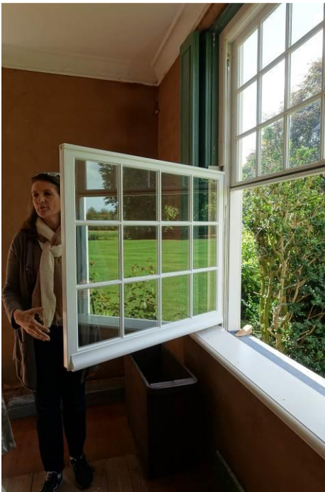
Afbeeldingen 7 en 8: Duurzaam aangepast. De vensters voorzien van gelaagd isolerend (renovatie)glas en van schuifnaar draairaam veranderd, op landgoed Bingerden. (Hielkje Zijlstra TUD, 19 september 2016)
