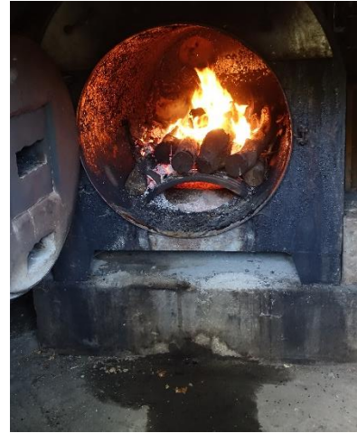
Afbeeldingen 5 en 6: Van huis uit duurzaam, de op hout gestookte verwarmings- en warmwater ketel van landgoed De Wierse. (Hielkje Zijlstra TUD, 6 november 2017)
