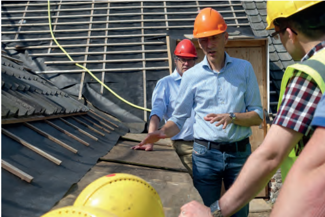
Afbeelding 23: Projectleider Ron Spaan vertelt over het werk op de De Erfgoedwerkplaats Reuversweerd, tijdens de cursus 'isolatie historische daken', die de GRC op locatie verzorgde op 12 maart 2019
