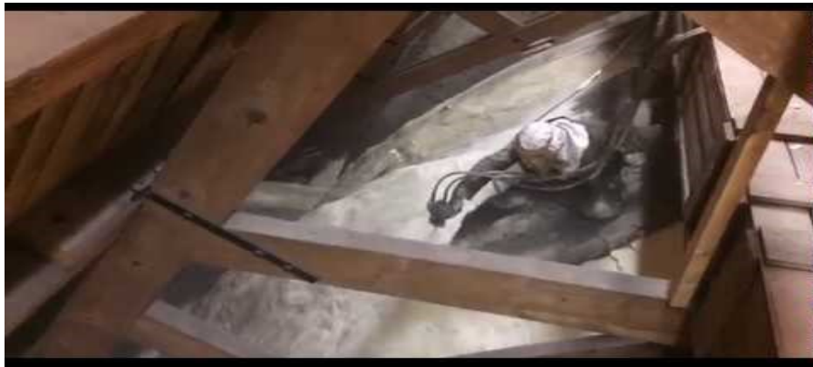
Figuur X Gewelfisolatie met gespoten PUR Oostelbeers kerk
