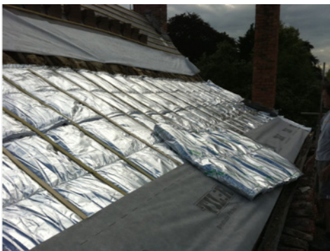
Afbeelding 8: Besproken technische oplossing: dunne multireflecterende isolatie
