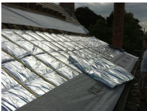
Afbeelding 8: Besproken technische oplossing: dunne multireflecterende isolatie
